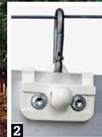
Foto 2 Nel sistema Powerflex la placchetta in combinazione con il moschettoni permette un'aerazione nella zona più alta del colmo (vedi cerchio nella foto 1)
