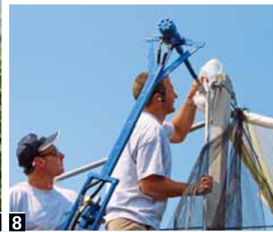
Foto 7-8 I motori per avvolgere e svolgere il telo nel sistema Solution vanno accoppiati al tubo di acciaio
